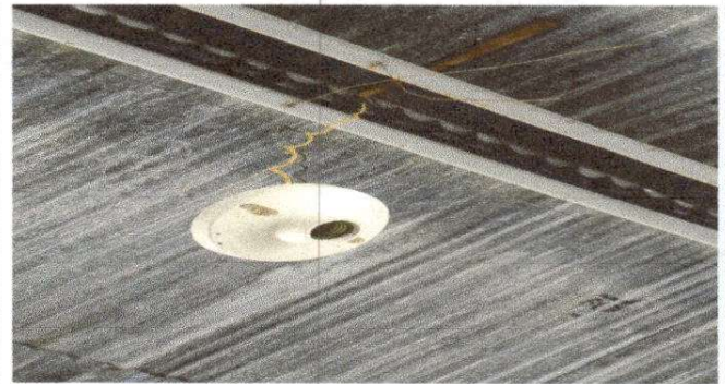
Foto 8. Sustitución de focos ahorradores
