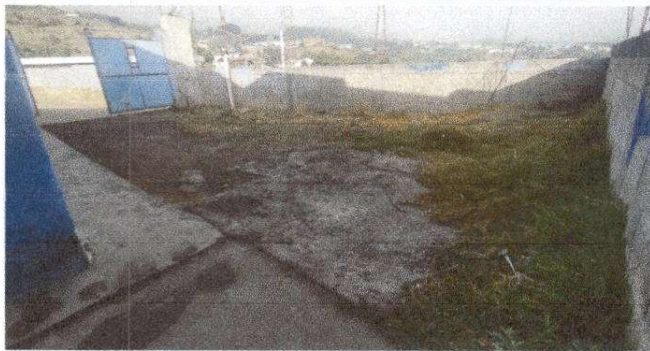
Foto 1: Reparación de piso de torta de concreto
