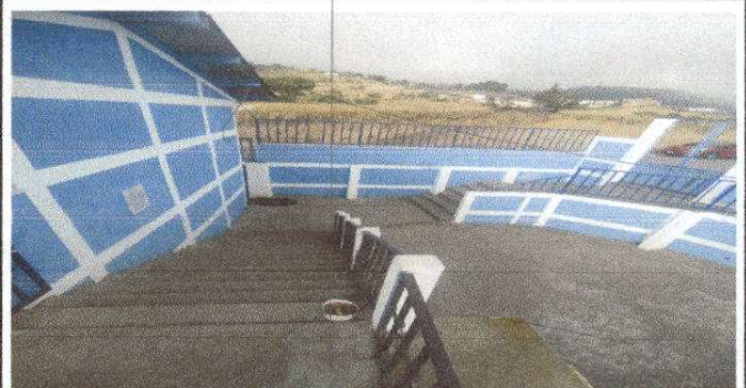
Foto 2: Sustitución de piso de torta de concreto (por ceramico antideslizante)
