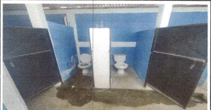
Foto 4: Sustitución de Inodoro
